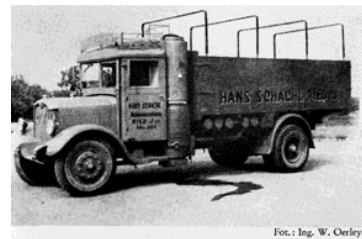
Abb. 1. Saurer 5 BHf, mit Holzgasantrieb.
